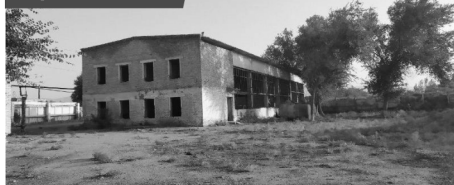
Электр подстанция, компрессор, қозонхона
