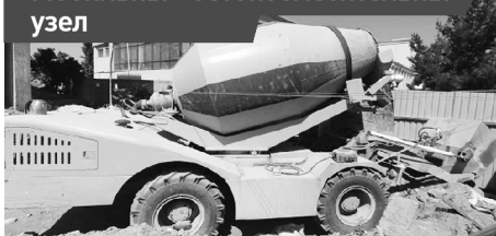
Мобильный бетоносмесительный узел
